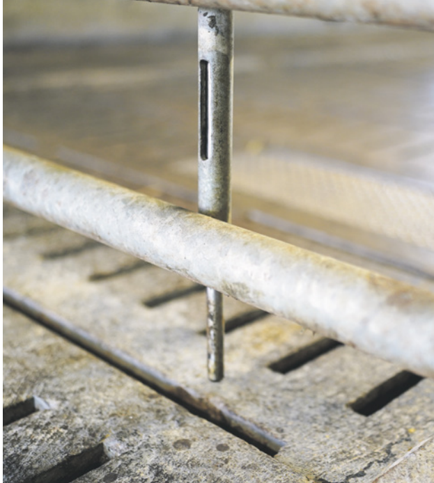
Das Gatter wird fixiert, indem zwei Metallstangen in die Bodenspalten versenkt werden.
